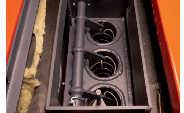
Fig. 6 : Tubes échangeur de chaleur avec turbulateurs
