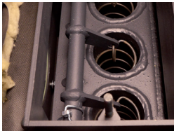
Fig. 7 : Turbulateur accroché
