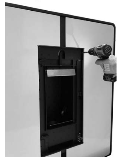
Fig. 41 - Fissaggio rivestimento
